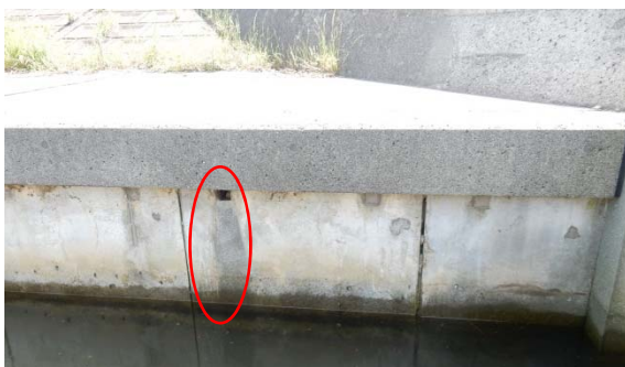
図-2 水路からの染み出し跡(平成28年撮影)
