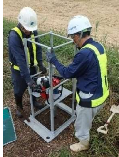
写真-3 掘削状況
